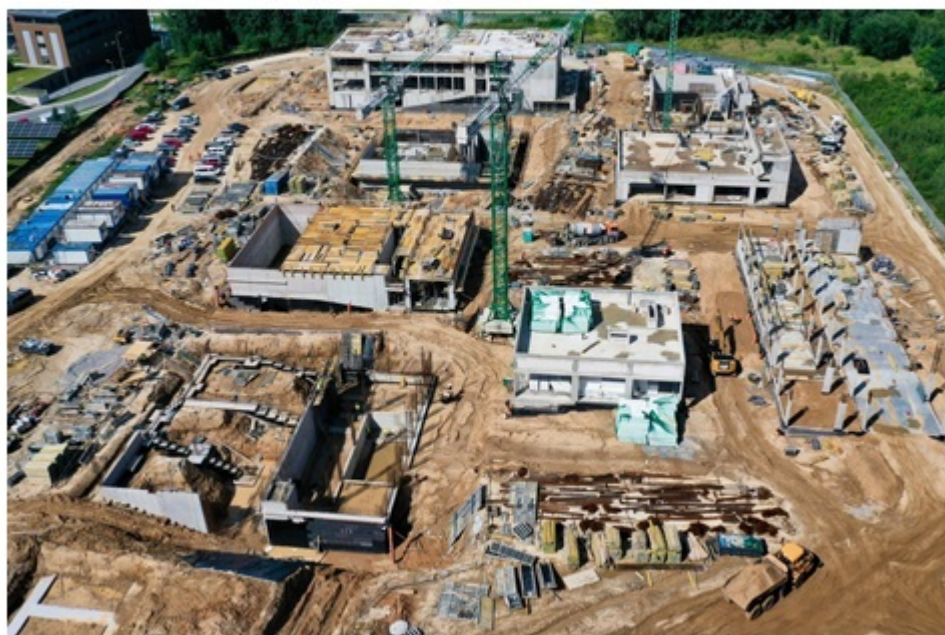
09.08.2021. Kielce. Budowa kampusu laboratoryjnego Głównego Urzędu Miar Fot. Jarosław Kubalski / Radio Kielce
