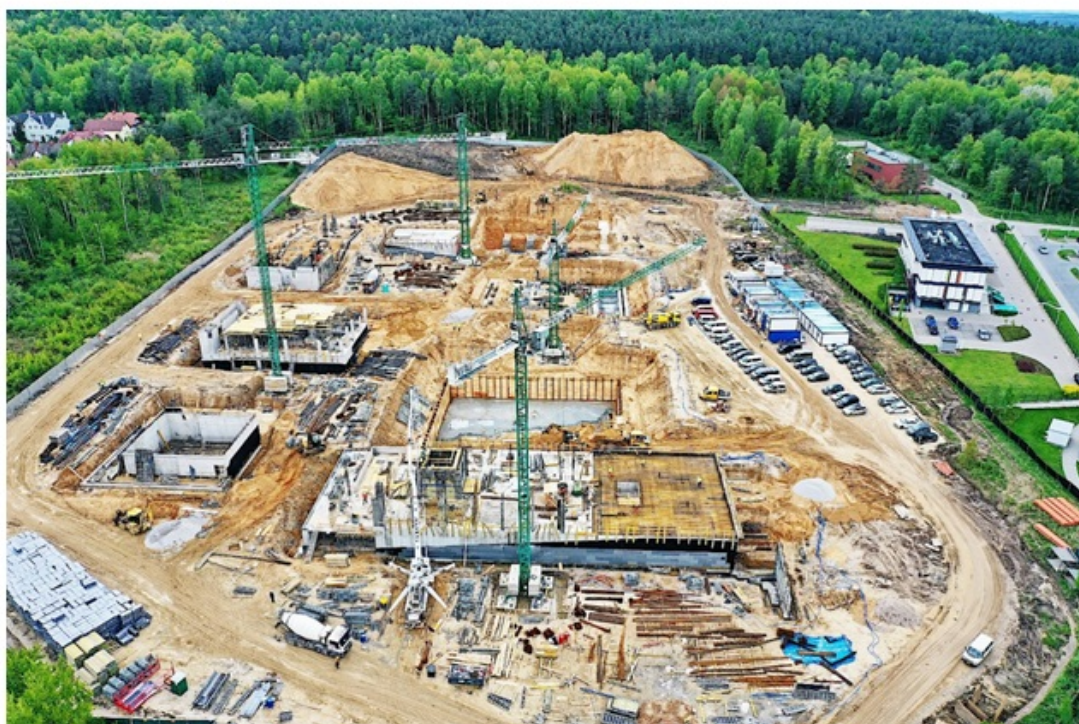
19.05.2021. Kielce. Główny Urząd Miar - plac budowy Fot. Jarosław Kubelski / Radio Kielce
